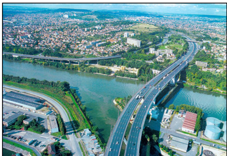
Viaduc de l'A15 au-dessus de la Seine et les buttes d'Orgemont
