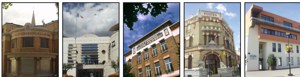
Les bains douches, l'hôtel de ville, l'école Volembert, l'hôtel des postes et la mairie de quartier du Val d'Argent Nord
