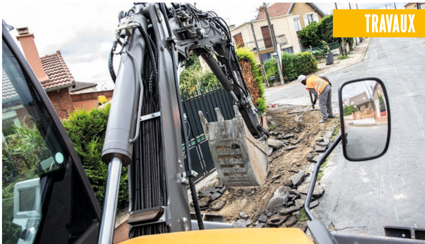
Rue du Perreux (VAS-VND) : rénovation complète de voirie
