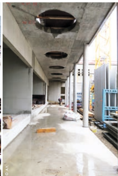
Le préau , dessus-dessous : des coupoles en polycarbonate habilleront les grands cercles évidés, pour laisser passer la lumière naturelle. Celle-ci pourra ainsi également éclairer les salles de classe
