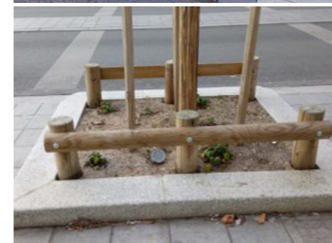
Plantation et protection en pied d'arbre d'alignement
