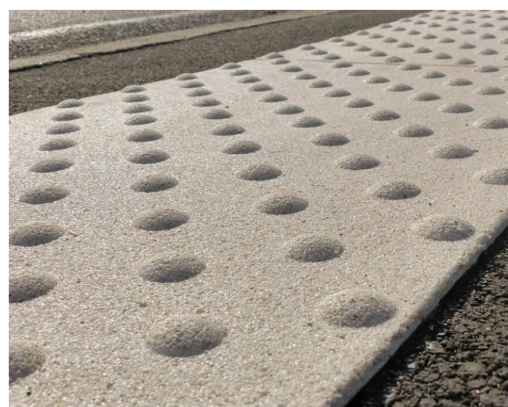
Section qualitative : dalle podotactile scellée
